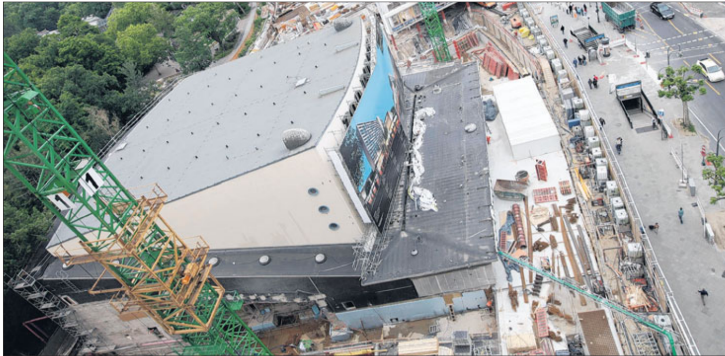
Das denkmalgeschützte Berliner Premierenkino Zoo Palast wird derzeit zum Edelkino umgebaut.
