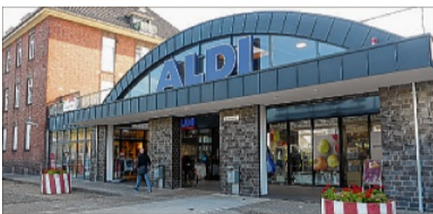
Der Aldi-Markt – modernisiert und erweitert.
